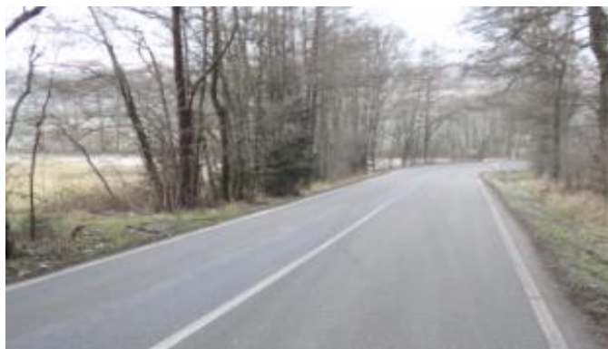
Obrázek č. 2 - Úsek silnice II/150 Ludíkov před pokládkou VDZ
