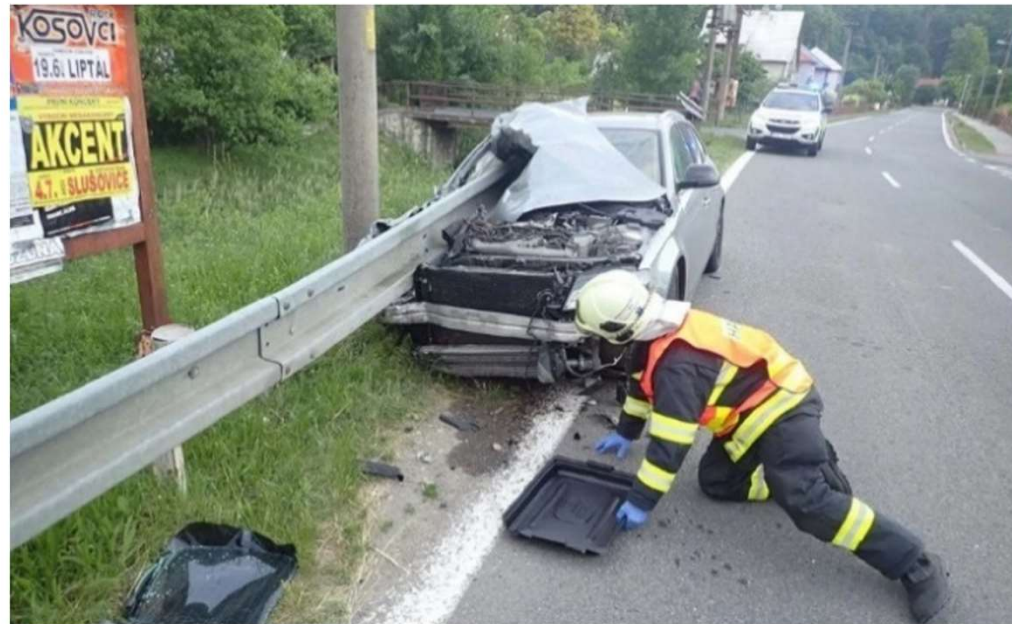
Obrázek 37 – Náraz do ocelového svodidla bez výškového náběhu. [40]
